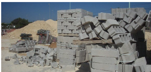
Rotura de material por acopio indebido
